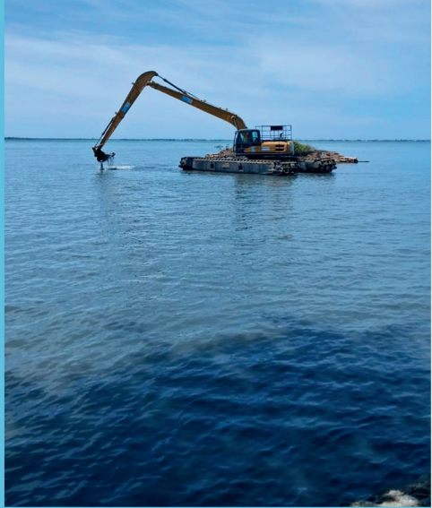
Desassoreamento na laguna de Araruama.
